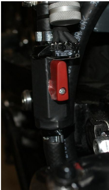
Absperrhahn in der Ölleitung zum Motor - Absperrhahn offen - Ölfluss freigegeben - Mikroschalter betätigt
